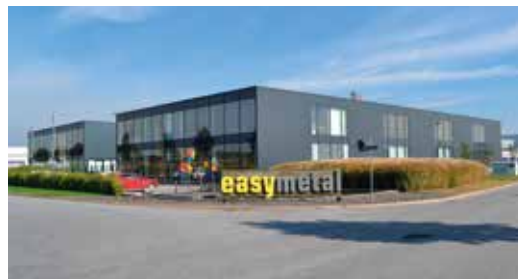
Produktion in der neuen Anlage.
